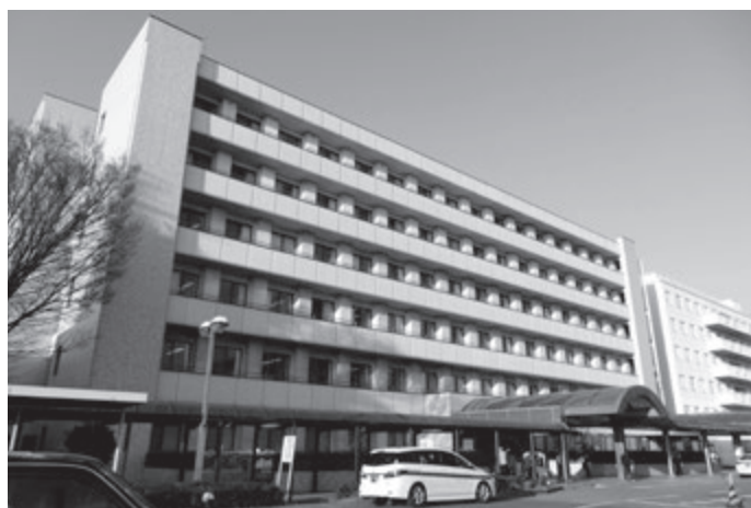
旧病院西病棟
