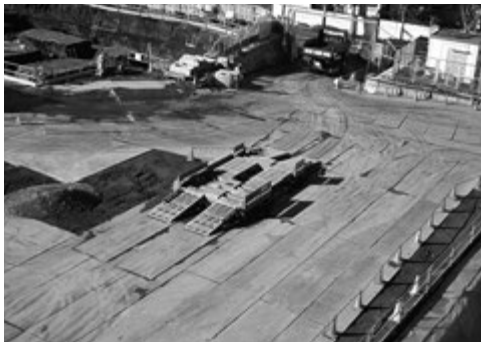
図22：H29.12.9 土をいじる基礎工事時期に置いてありました。
