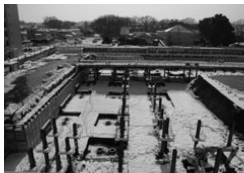
図17：H30.1.23 写真奥から剥きだされた鉄骨の上に鉄板が乗り、橋のような構造物が出来てきました。
