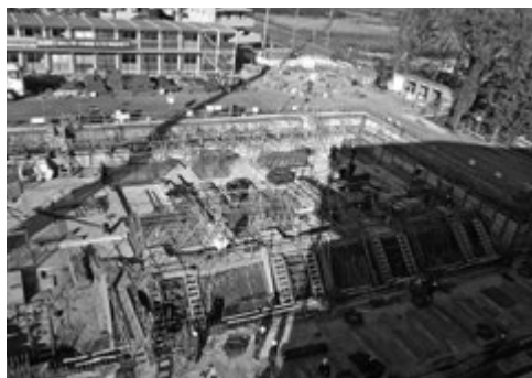
図12：H30.1.6 別館の地下部分を頑丈に建築中。
