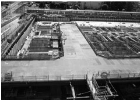
図20：H30.4.8 工事が完了し、お役御免となった写真奥から撤去が始まり、
