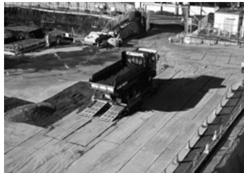
図23：答え。ダンプカーのタイヤ掃除機でした。一般道に出る前の泥落としです。
