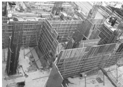
図15：H31.2.2 年が明けたら工事再開、すぐに立体駐車場より高くなりました。
