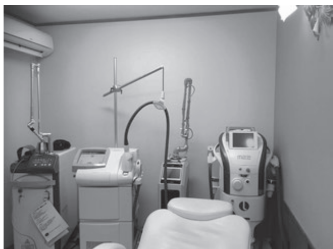
自宅の玄関を2階に移動して増設したレーザー室
